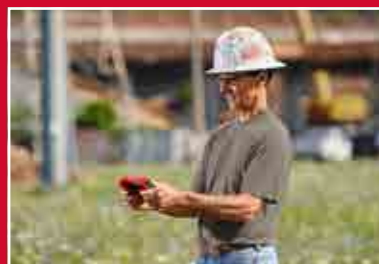
Bezdrôtové diaľkové ovládanie komunikuje s náradím a umožňuje vykonať rezy
